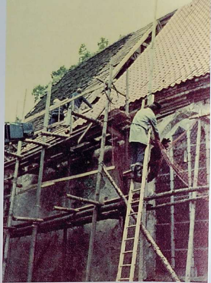
Abb. 4 Hölzerne Einrüstung für die Dacharbeiten an der Kirche im Jahre 1986.
