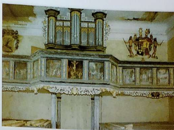
Abb. 6 Feuchtigkeitsschäden an der Decke im Bereich über der Orgel 1987.
